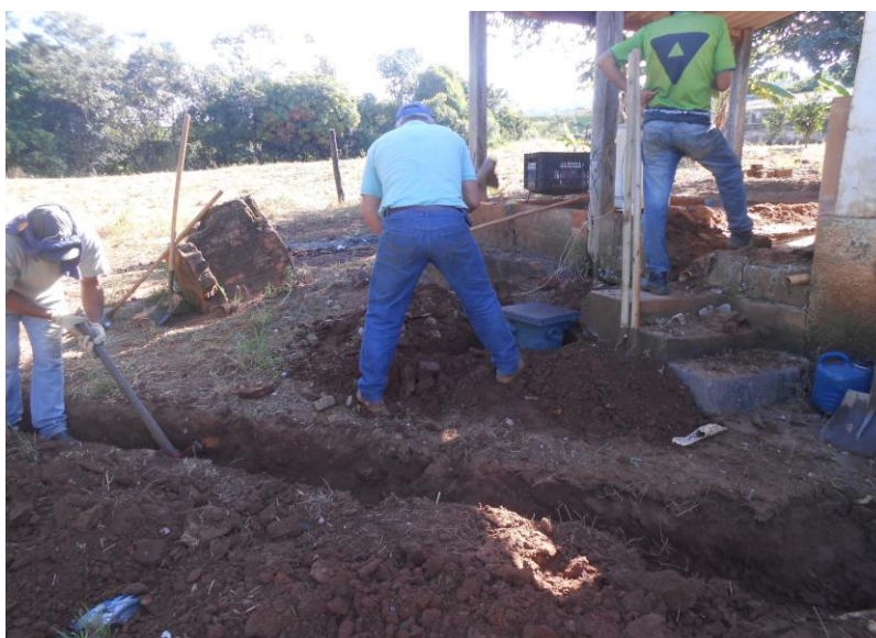
Figura 09: Construção de fossas na comunidade Mercês
